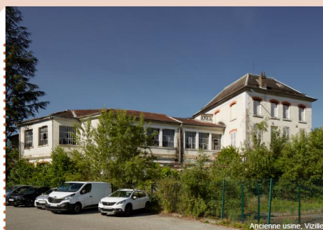
Ancienne usine, Vizille
