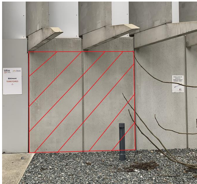
09 Entrée bâtiment I
