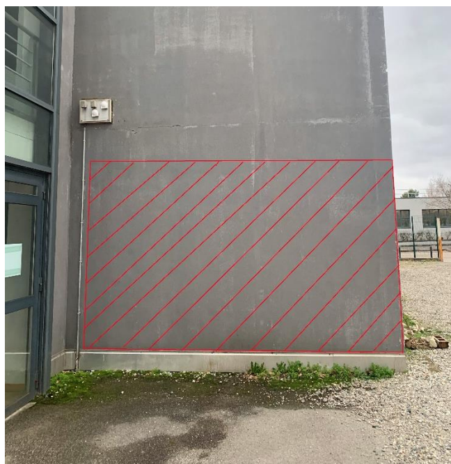
06 Mur bâtiment G
