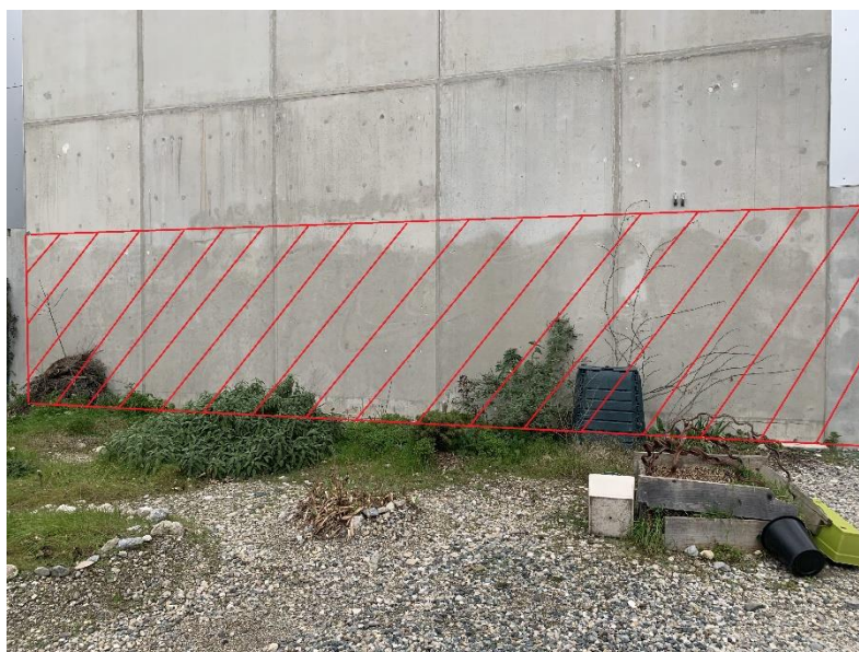
07 Espace jardin bâtiment T
